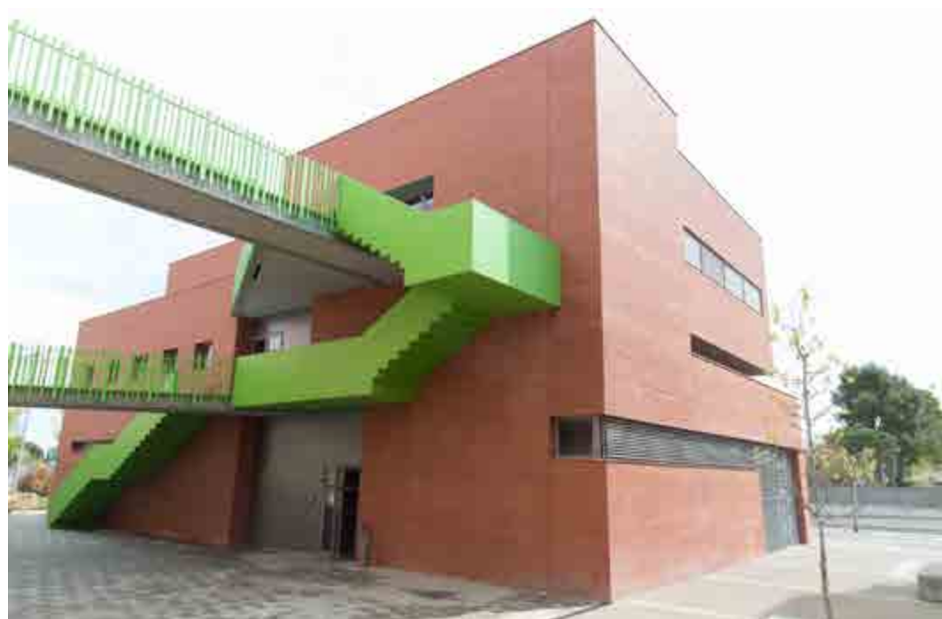
Edifici Serveis Hospitalaris Veterinaris
